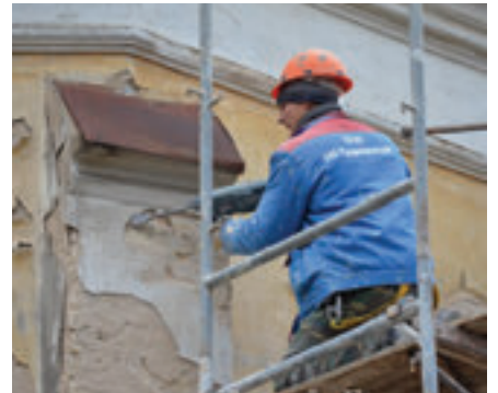
Die Restaurationsarbeiten laufen in vollem Gange
