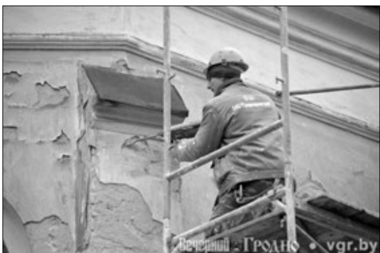
РЕСТАВРАЦИОННЫЕ РАБОТЫ ИДУТ ПОЛНЫМ ХОДОМ
