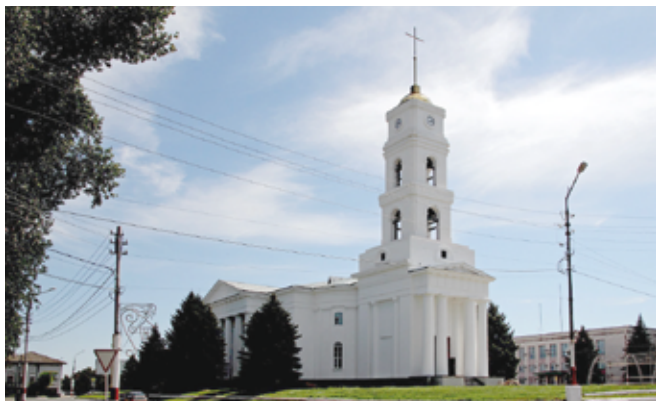
Dreieinigkeitskirche in Marx nach der Restaurierung
