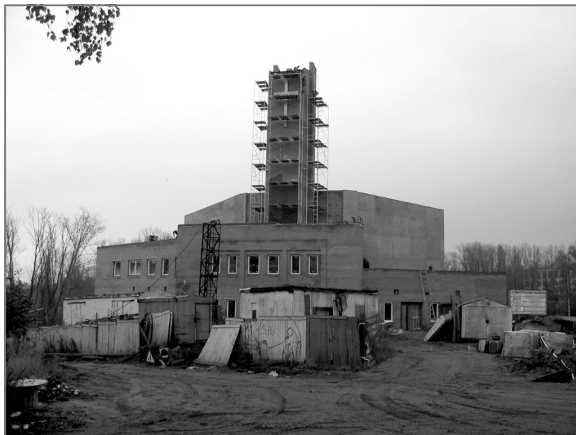
Вид строящейся евангелическо-лютеранской церкви в Петрозаводске
