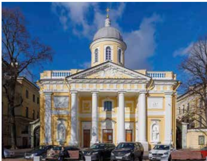
Ein grandioses Geschenk für die Gemeinde zum Einweihungsjubiläum war die Restaurierung des Gebäudes, die im August dieses Jahres endgültig abgeschlossen wurde...
