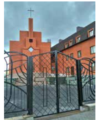
Der neue Kirchenkomplex – bestehend aus dem Kirchengebäude selbst und einem Kirchenzentrum – wurde innerhalb von nur zwei Jahren und zwei Monaten aufgebaut...
