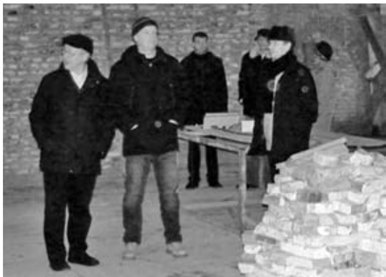
АРХИТЕКТОР ХАНС-ЙОРГ БЛЮМ (ВТОРОЙ СЛЕВА) ОСМАТРИВАЕТ ФРОНТ РАБОТ
