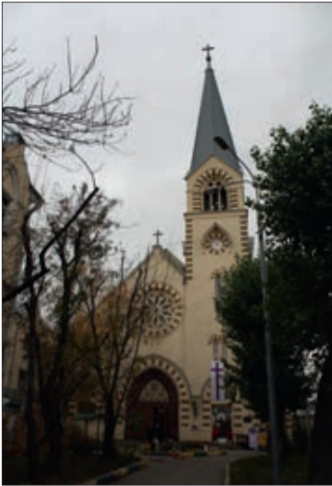
Собор свв. Петра и Павла в Старосадском переулке был построен в 1905 году по проекту архитектора Виктора Коссова. В советское время здание переоборудовали под кинотеатр «Арктика», а затем под студию «Диафильм». С 1991 года община снова получает доступ к зданию...
